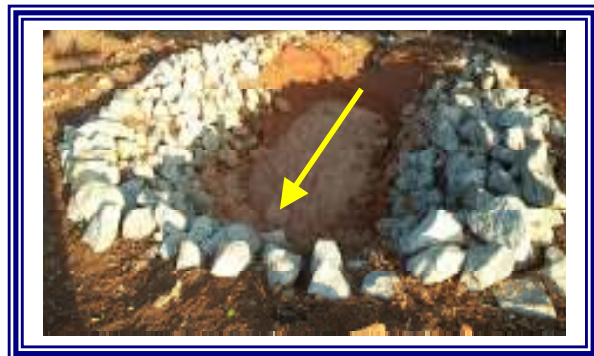
Rock Sediment Dike
